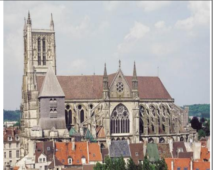
Cathédrale St Etienne Meaux. 12 ième s (début de construction). Seine et Marne
