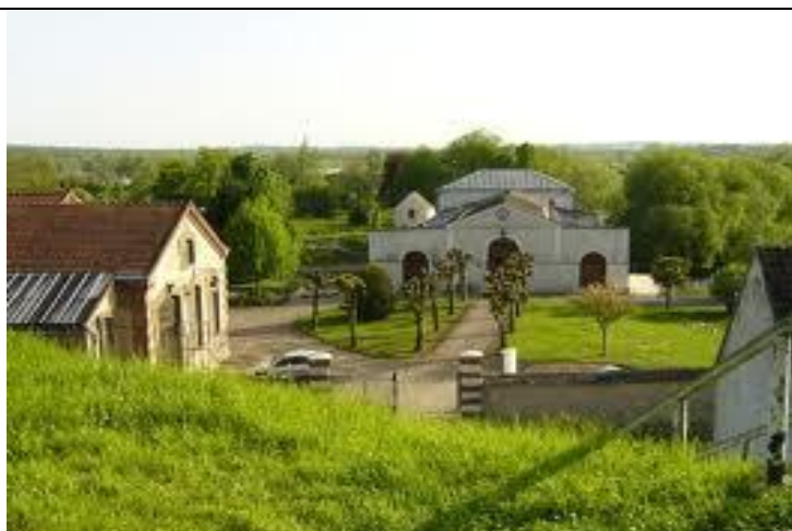
Usine élévatoire de Trilbardou. 19 ième s Seine et Marne
